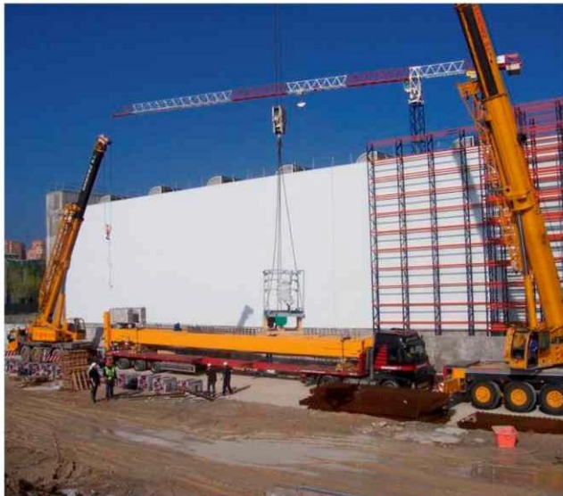
Montaje de estructura transportadora, leche Pascual, Madrid, España
