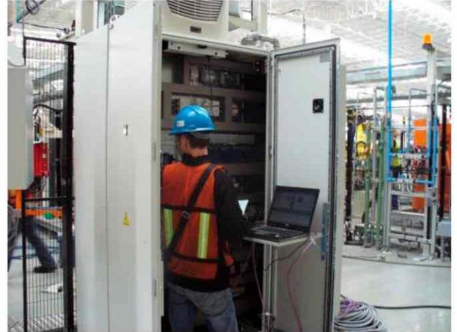
Programación de PLC's SIEMENS Gestamp, Toluca, México
