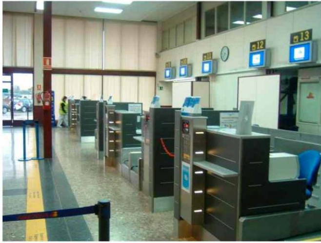
Colocación de transportadores de maleteros, Barajas, Madrid, España
