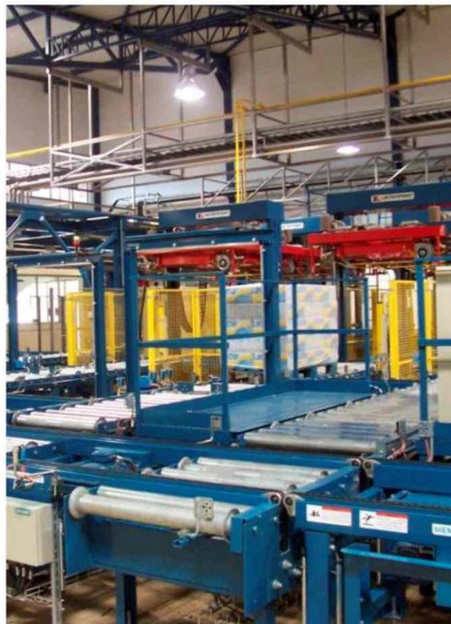
Montaje de transportadora, leche Pascual, Madrid, España
