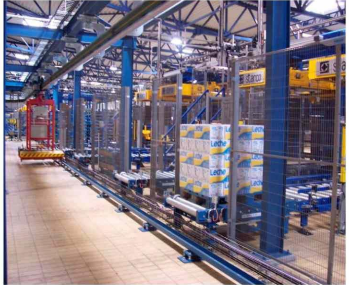
Montaje de estructura transportadora, leche Pascual, Madrid, España
