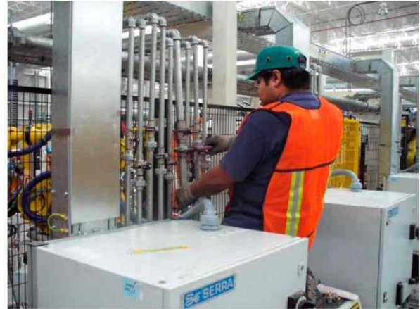
Montaje de líneas neumáticas Gestamp, Toluca, México
